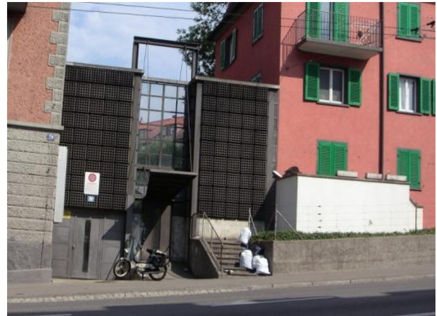
Lärm an der Hausfassade
